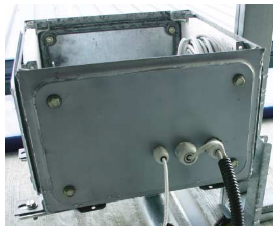
Der Schaltkasten ist mit etwas Styropor isoliert. So soll die Verlustwärme des Access Points die Temperatur im Kasten auch im Winter über dem Gefrierpunkt halten. Das DSL-Modem steckt in einem zweiten Kasten im Gebäudeinneren.
